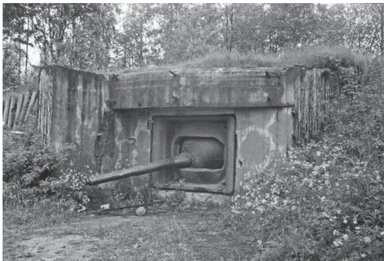
Рис.9. Сооружение Карельского УРа, вооруженное 100-мм казематной пушкой ЗИФ-25. Фото Ю. Иванов (Владивосток)
