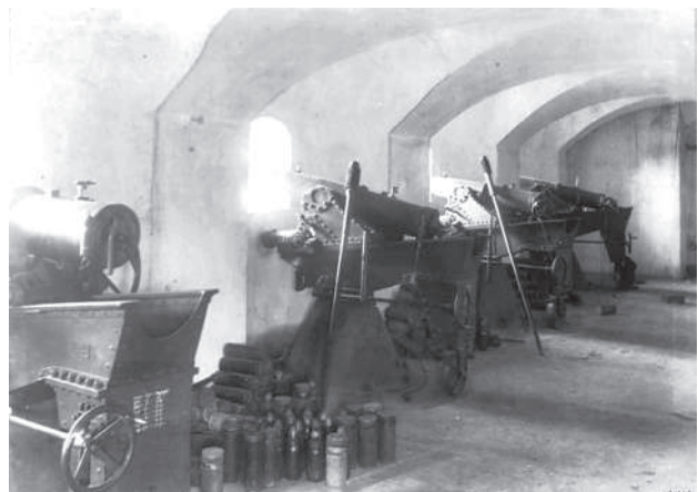
Рис. 5. Крепость Ковно. Тумбовые лафеты конструкции Дурляхера для полевых пушек в промежуточном капонире форта. На фото лафеты и пушки поздних выпусков. Фото размещено Владимиром Орловым (Каунас) на сайте www.fortification.ru
